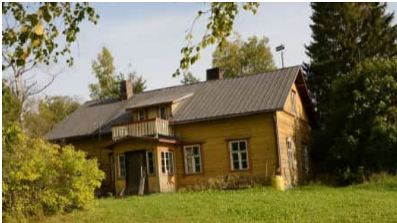
Vuonna 1928 hirrestä rakennetun asuinrakennuksen lasitetun kiustin yläpuolella oleva katoton parveke ja frontoni on harvinainen ratkaisu.
