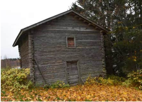
Kaksikerroksinen eloaitta on 1800-luvulta. Nurkkasalvoksen hirret ovat aikojen saatossa syöpyneet melko hatariksi.
