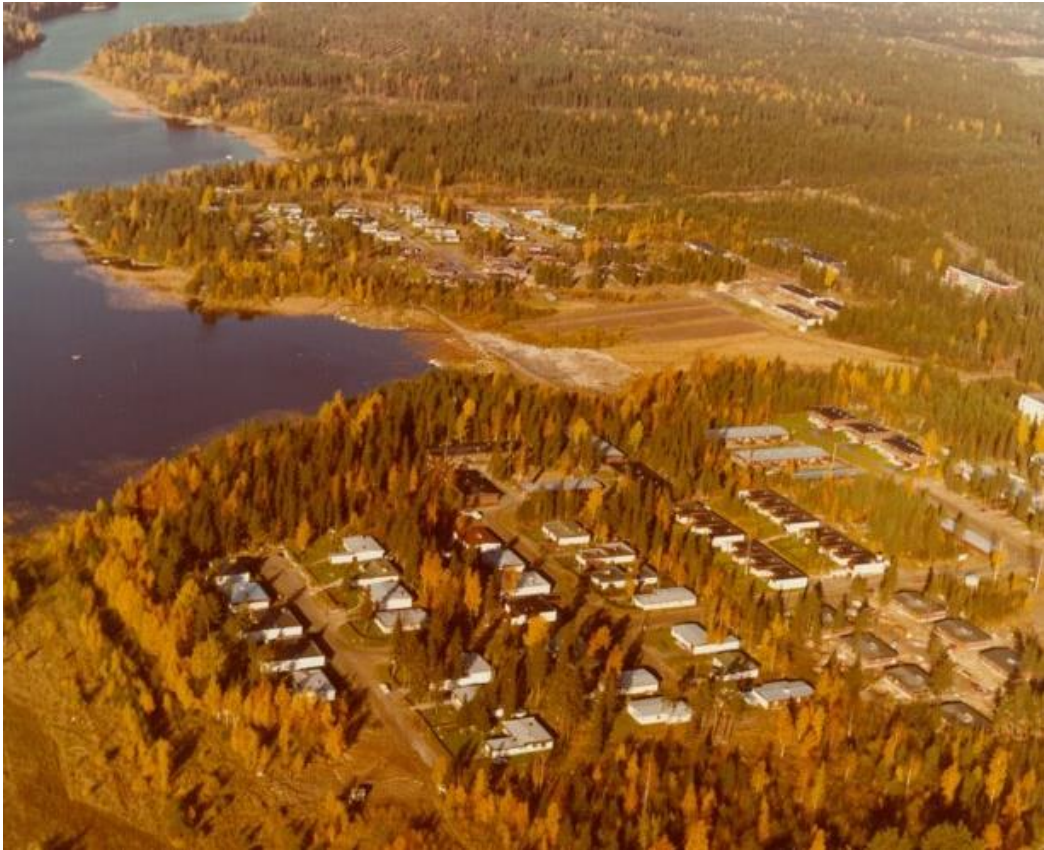
Kuva 23. Vuorelan taajama rakentuu
