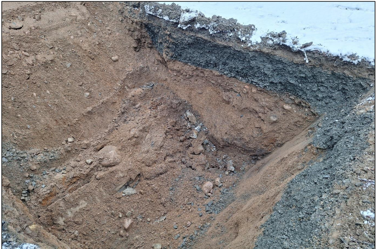
Kuva 6. Tutkimuspiste KK3, jossa todettiin kohonneita kuparipitoisuuksia kuvassa harmaana näkyvässä täyttökerroksessa.
